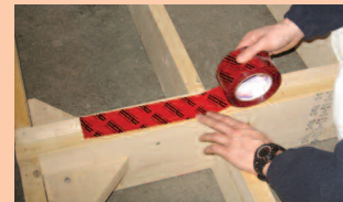
1 Pose sur ruban pare-adhérence
