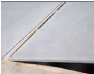
Installation du panneau subséquent.
