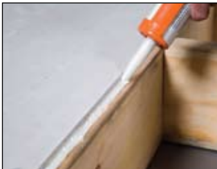
Application du scellant adhésif.
